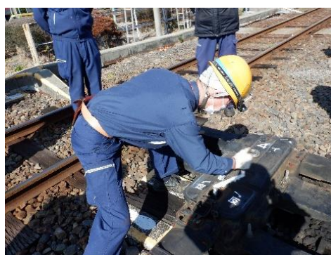
転てつ器手動扱い訓練（異例時対応訓練）の様子
