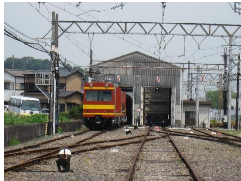
東方操車場と電貨車両
