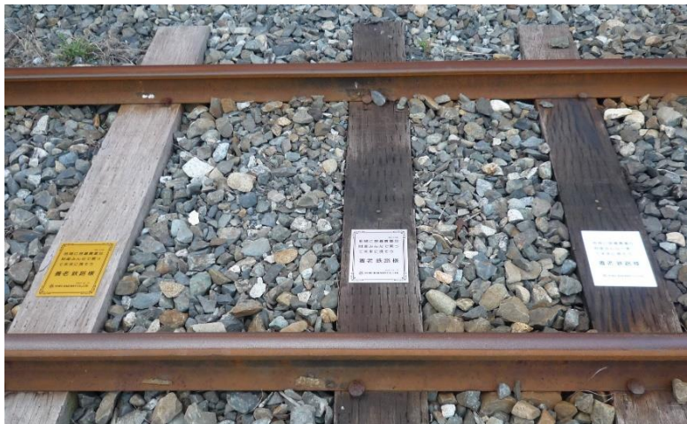
オーナープレート設置状態
